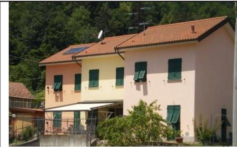
**Tipologia a blocco:** si tratta di edificio isolato con elemento distributore verticale interno centrale a una o più unità abitativa per piano. Preferenzialmente la copertura è a padiglione e le bucatore con allineamenti orizzontali e verticali
