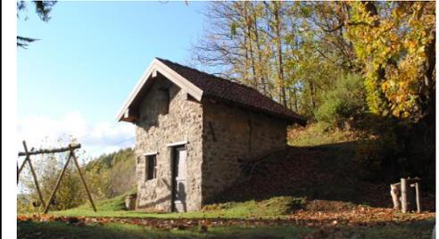
**Legnaia:** strutture semplici per il ricovero del legname realizzate prevalentemente con lo stesso materiale in legno (cfr. esempio da foto a margine) o con struttura esterna in muratura e dotate di copertura a falda inclinata, ultimata con tegole marsigliesi, coppi rossi, lamierino zincato a doghe testa di moro
